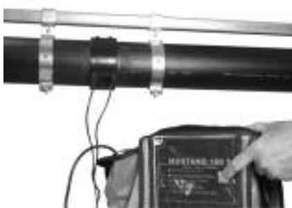
Slika 59. Pravilno izvedeno učvršćivanje prije zavarivanja.
