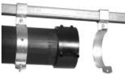
Slika 58. Montirati privremenu obujmicu cijevi u blizini spojnice za dobivanje kružnog oblika.
