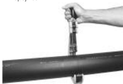
Slika 51. Po mogućnosti, koristiti cijevnu obujmicu.
