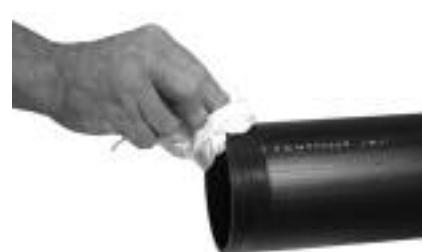
Slika 54. Očistiti cijev PE čistačem
