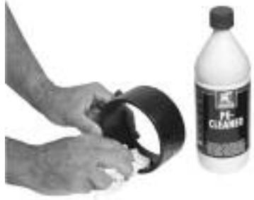
Slika 57. Očistiti unutrašnjost spojnice pomoću PE čistača.
